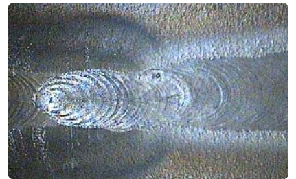
Inspection de soudures
