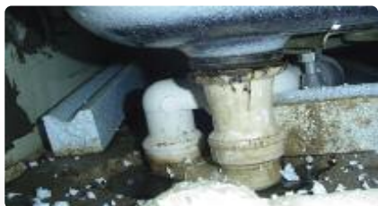
Contrôle des sous-structures de baignoire
